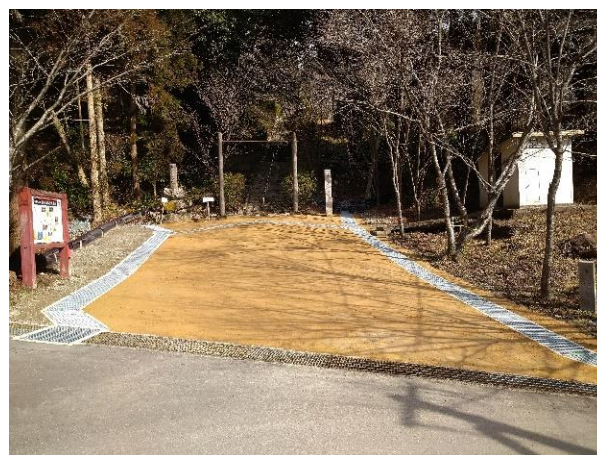
F.筑紫氏館跡地区災害復旧工事
