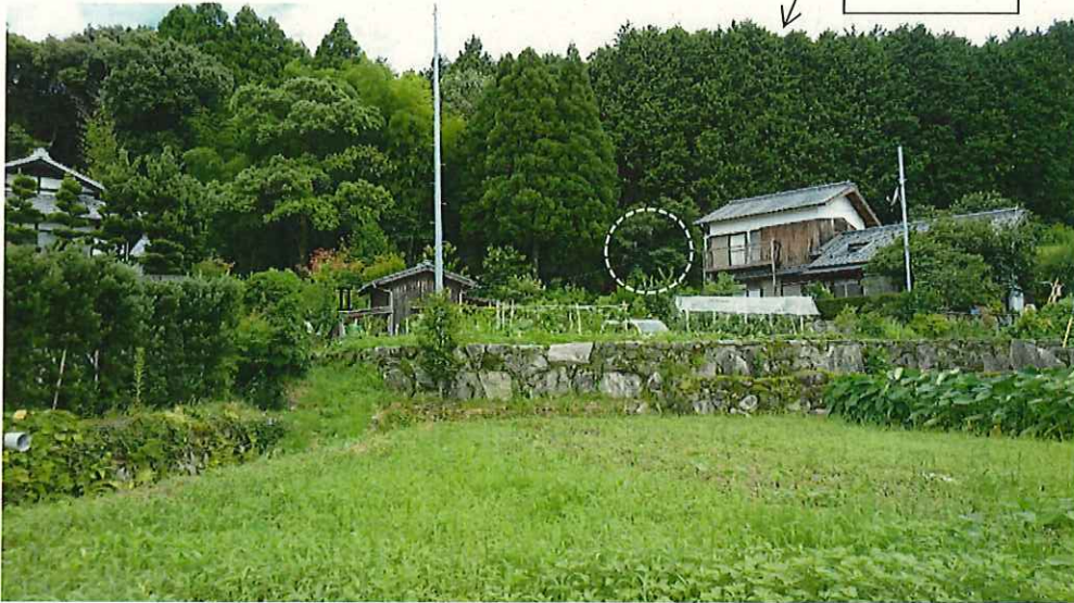
被害箇所（白破線）
