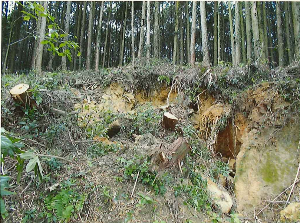
復旧前（東から）
