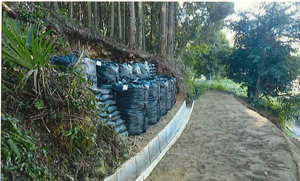
復旧後（南から）
