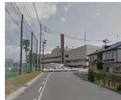
②西側市道から現庁舎をみる
