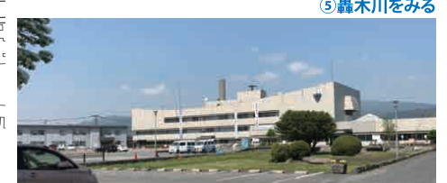
⑥敷地南東部から現庁舎をみる
