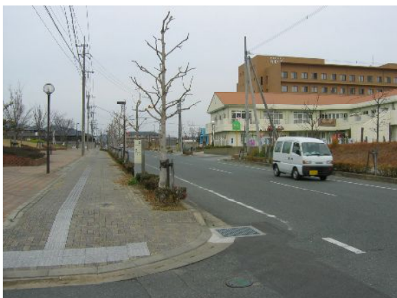
▼都市計画道路として整備が完了した道路 (計画幅員16mで整備された道路)
