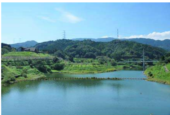
九千部山と河内防災ダム
