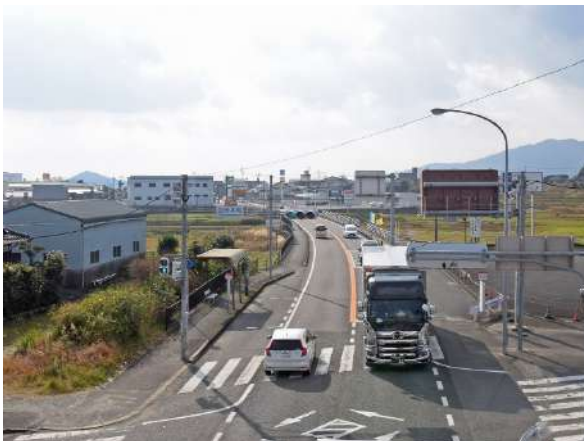
都市計画道路永吉中原線（国道34号）
