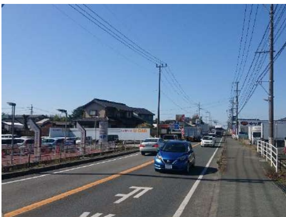
都市計画道路永吉中原線（国道 34 号）
