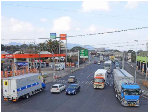
都市計画道路永吉高田線（国道3号）
