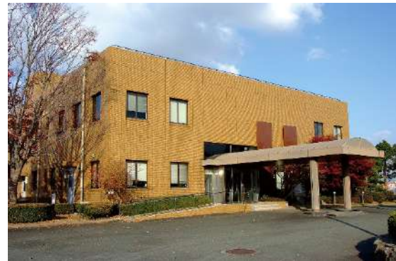
鳥栖市浄化センター
