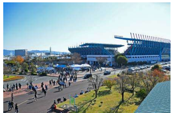
鳥栖スタジアム（駅前不動産スタジアム）
