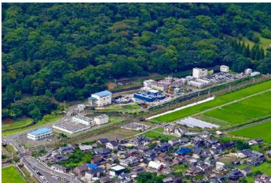
鳥栖市浄水場
