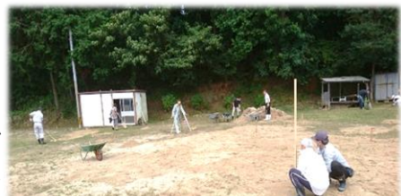
After: レベルを取り、整備していただきました
