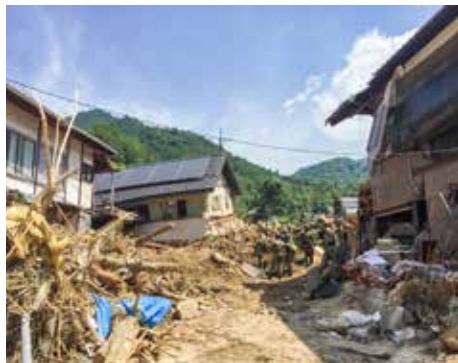
豪雨災害の被災状況（天応地区）
