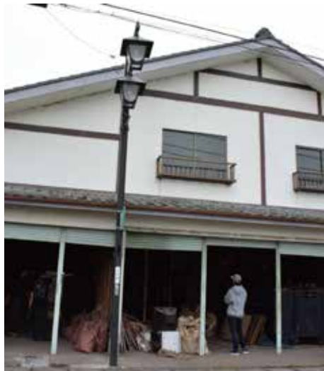
リノベーション前の空き家
