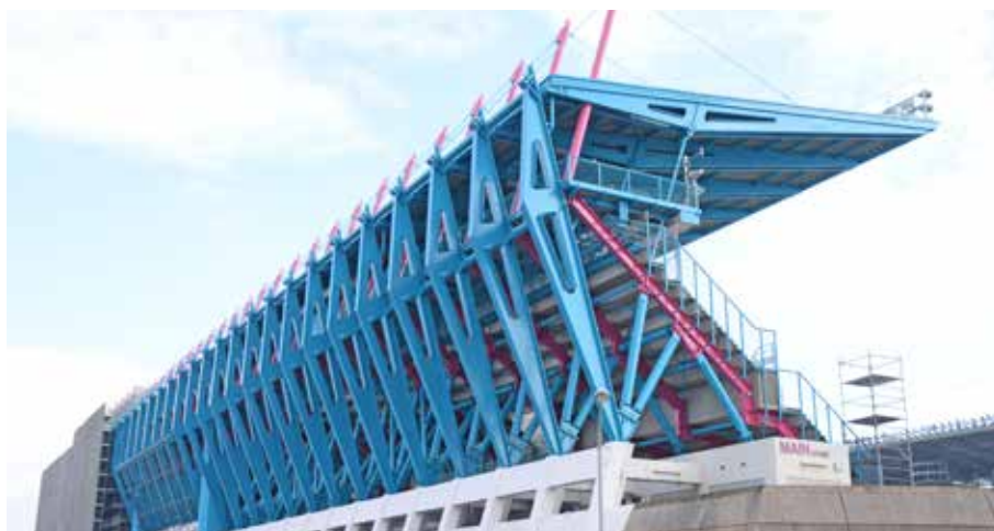
改修が進むスタジアム。外観は市内遺跡出土の銅剣がモチーフ。
