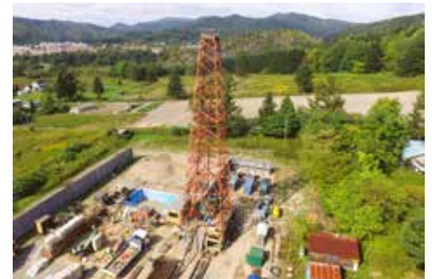
CBM 試掘・生産テスト現場
