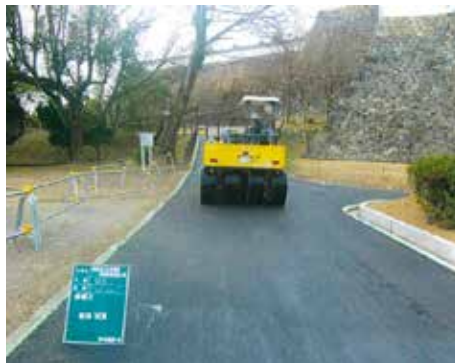
園路舗装の様子
