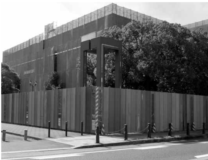
大規模改修中の市民文化会館
