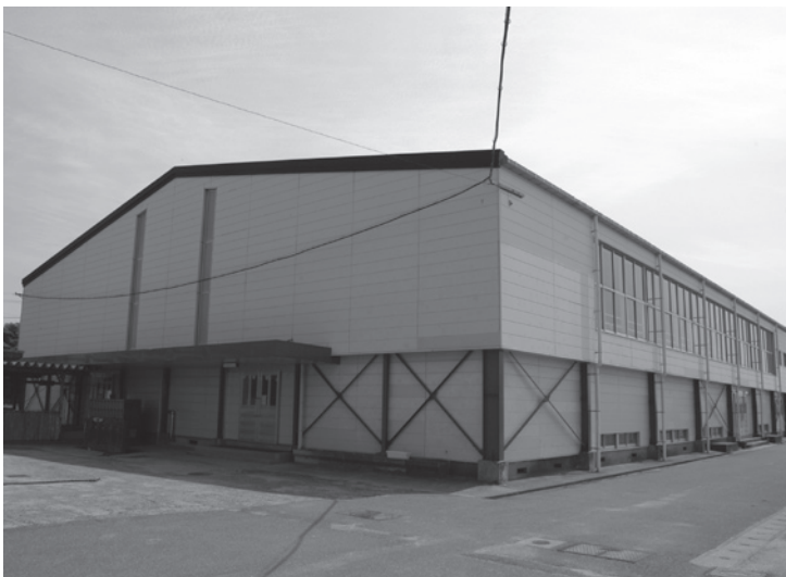
大規模改修工事を行った鳥栖西中学校体育館
