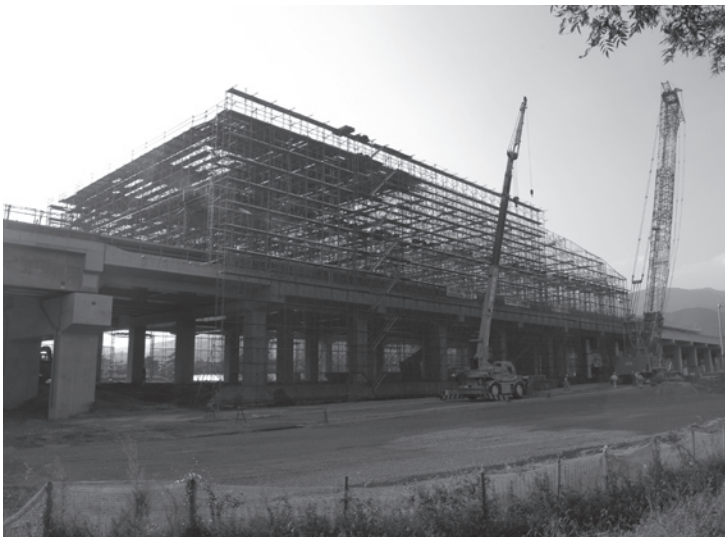
建設が進む九州新幹線の新鳥栖駅
