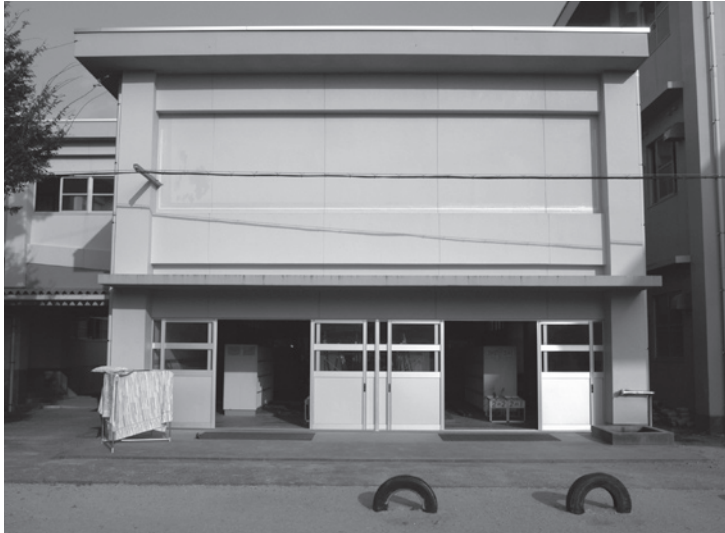
耐震改修工事を行った基里小学校の昇降口
