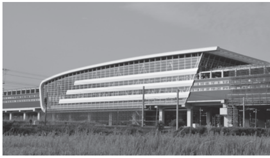
建設が進む新鳥栖駅
