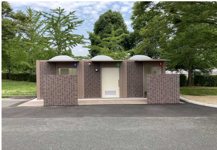
第2駐車場トイレ
