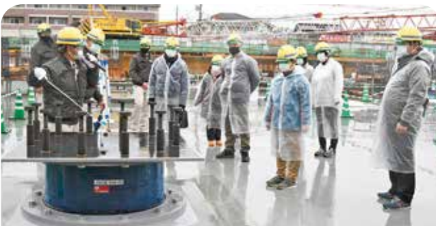
当日は工事が進むと見られなくなる「免震装置」を主に見学
