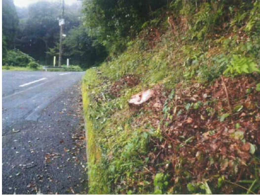
支障木伐採(通行車両の利便性向上)
