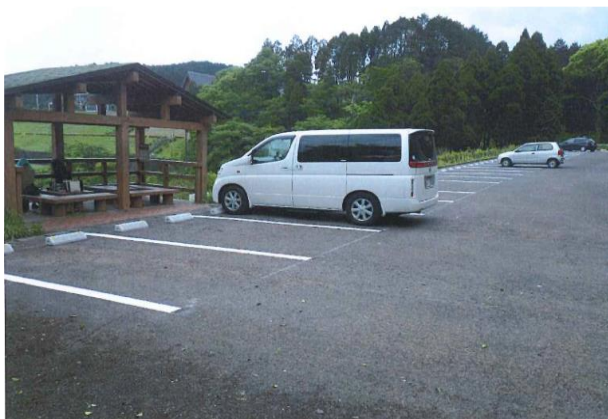
駐車場のライン引きと車止めの設置
