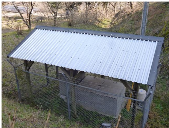
破損した屋根を補修（機能保全、景観保護）
