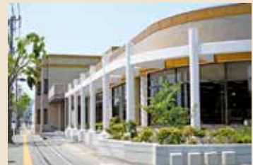
▲現在の市立図書館。外壁の塗装や駐車場の改修工事などを昨年度行いました
