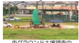
市グラウンド土壌調査中
