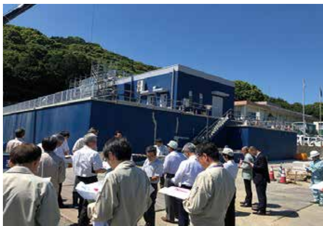
浄水場急速ろ過池工事現場
