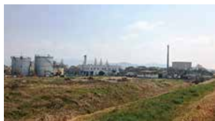
次期ごみ処理施設建設予定地
