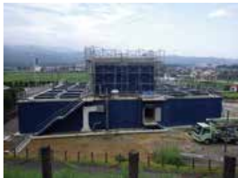
浄水場急速ろ過池工事現場
