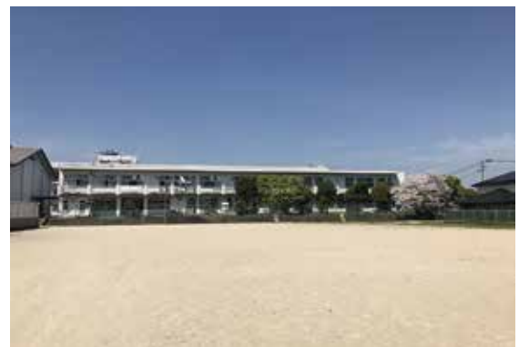
大規模改修が予定されている田代小学校
