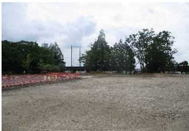
日本庭園樹木等撤去・造成完了状況
