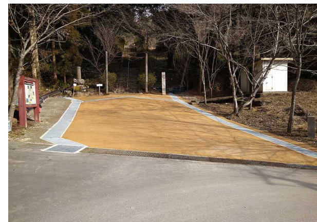
筑紫氏館跡防災対策工事
