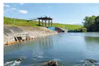
上水道の取水口付近
