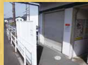
肥前麓駅トイレ（閉鎖中）
