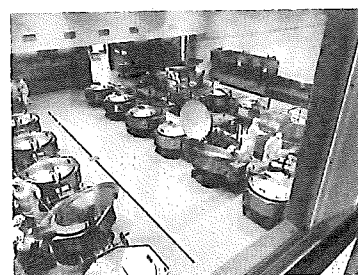
給食センターの施設内
