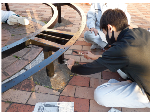
⑤フレーム錆止め塗装
