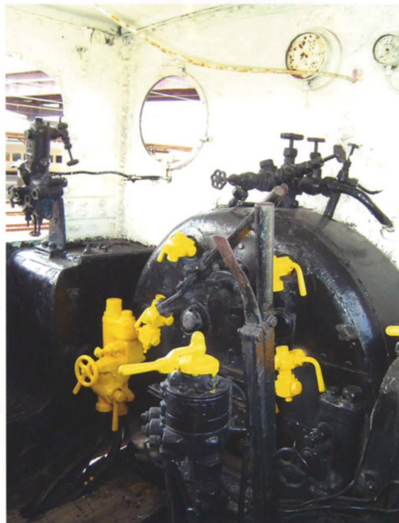
キャブ（運転室）内部
