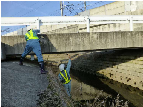
定期点検の状況
