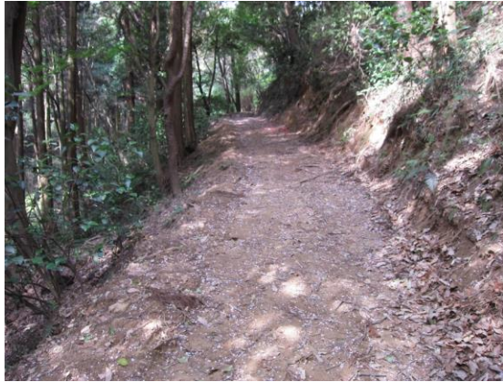
遊歩道の拡幅整地
