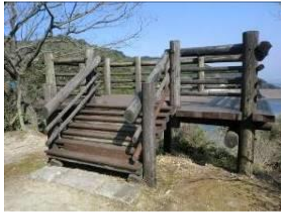
展望台床腐食部分の補修
