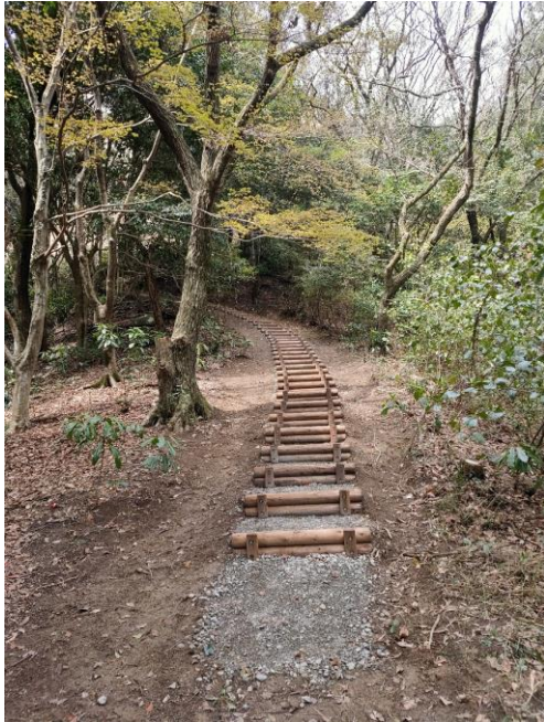
遊歩道階段設置(利便性向上、危険防止)
