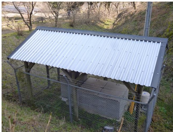
破損した屋根を補修（機能保全、景観保護）
