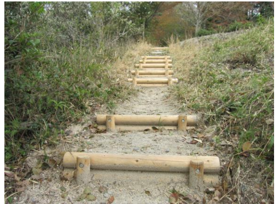
腐食階段の改修
