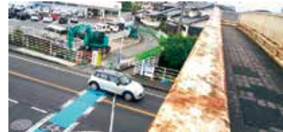
「環境整備」が進む 工事現場
