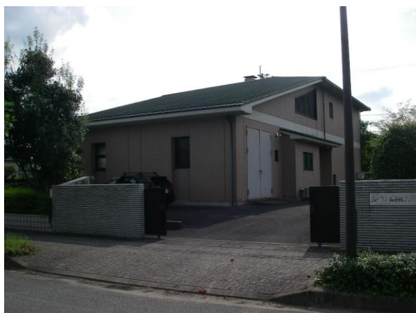
北部中継ポンプ場
