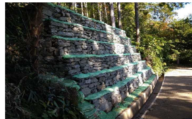
葛籠城跡地区防災対策工事
