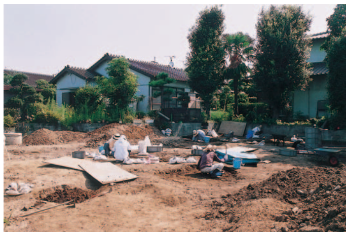
8. 作業風景 (南から)
