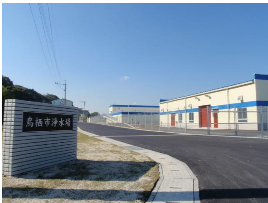
鳥栖市浄水場（鳥栖市原古賀町）
