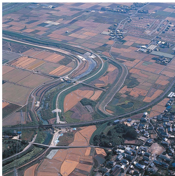
写真1 霞堤全景（北から）
