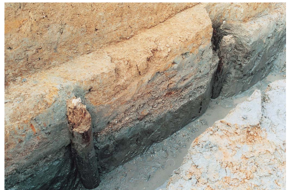
写真14 第4堤防木杭（東から）
