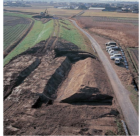
写真5 第2堤防（北から）
