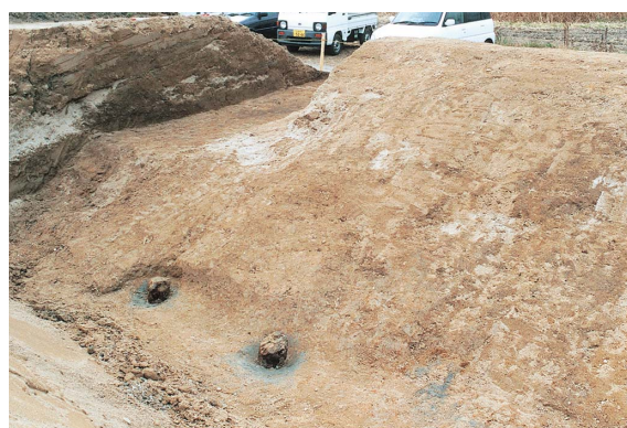
写真7 第2堤防木杭（東から）
