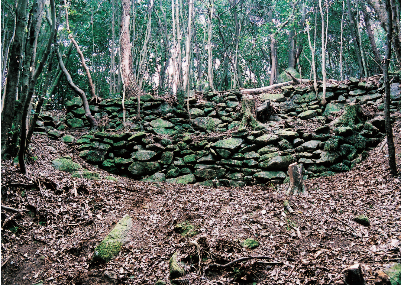
2. 勝尾城石垣（北から）
