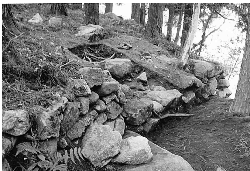
2. C地区8トレンチ並びに 石積み状態
