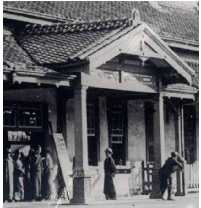
写真 3-14 大正 14 年頃の車寄せ 建設当初と変わらない妻飾りで、まだ時計も金属の持ち送りが付いていない (『鳥栖商工案内』鳥栖商工会 1925 より転載)
