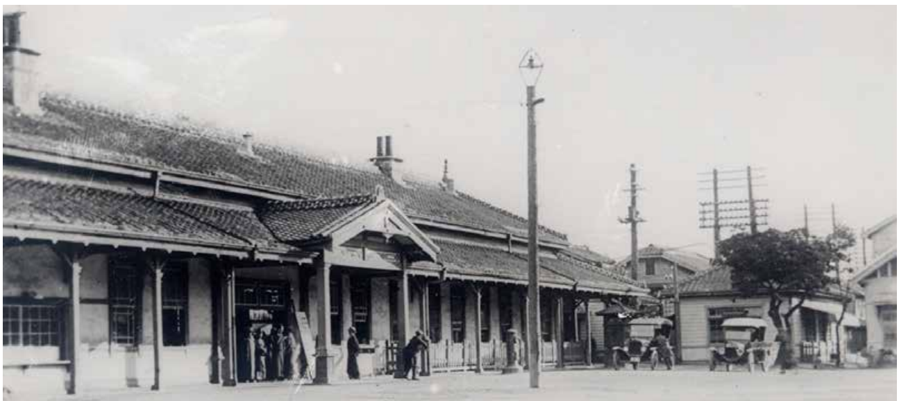
写真 3-2 大正14年(1925)頃 下屋の鼻板飾りや2基の煙突は残る 時計はまだ設置されていない (『鳥栖商工業案内』鳥栖商工会 1925より転載)
