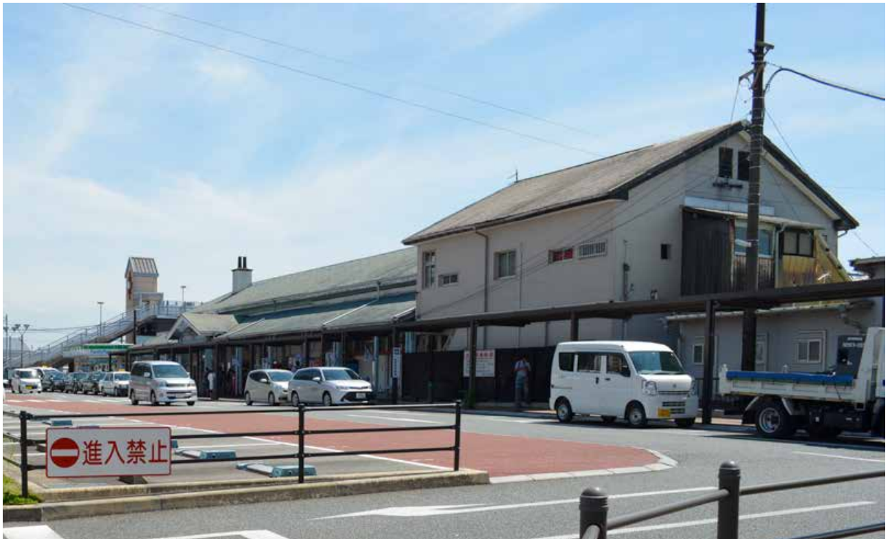
写真 3-9 南西から見た現在の駅本屋外観
