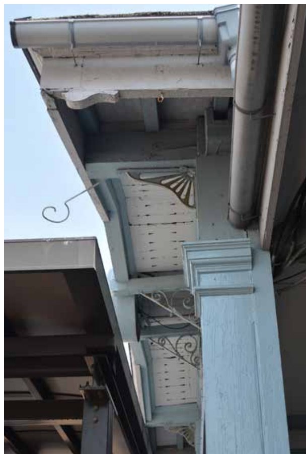
写真 3-17 車寄せの軒裏は換気口を細工した小板貼り アールデコの金属持ち送りは昭和になって付いた
