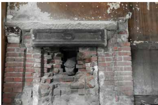
写真 3-13 「参等待合室」と「荷物取扱室」との境の暖炉 (鳥栖観光コンベンション協会提供)
