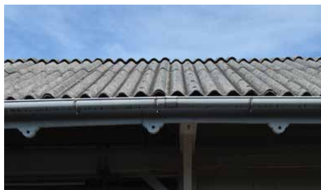
写真 3-10 現在も残るプラットホーム屋根の鼻板飾り
