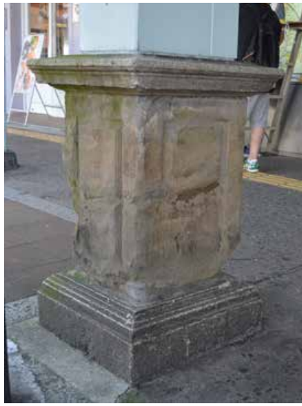
写真 3-19 車寄せ独立柱の基壇
