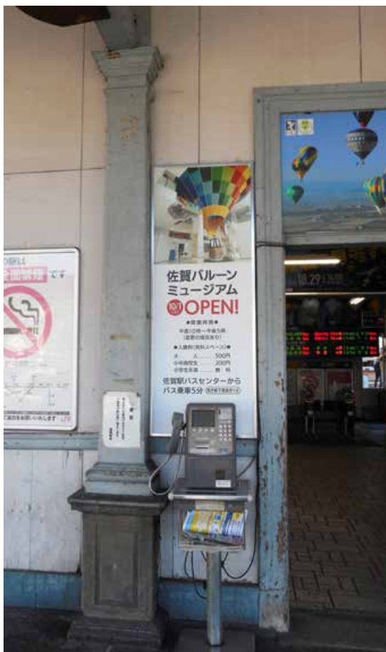
写真 3-16 出入口に設けられた付け柱
