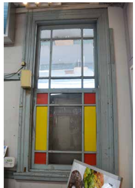
写真 3-24 内部から見た上げ下げ窓
