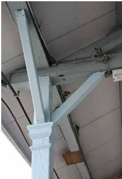
写真 3-18 下屋柱上部の構造
