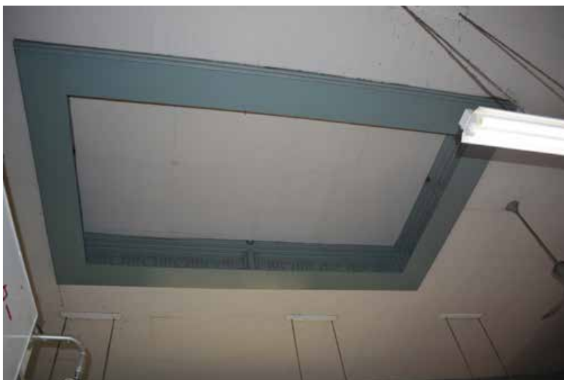
写真 3-23 「参等待合室」であった現待合室の折上げ天井
