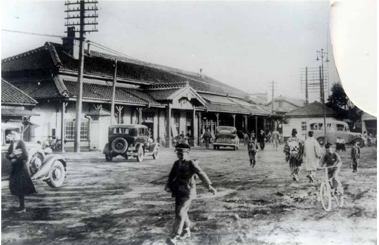
写真 3-4 昭和 10 年 (1935) 頃 下屋の鼻板飾りはなくなり、南側の煙突も撤去されている。時計が車寄せ正面に設置されている。(篠原眞氏写真提供)
