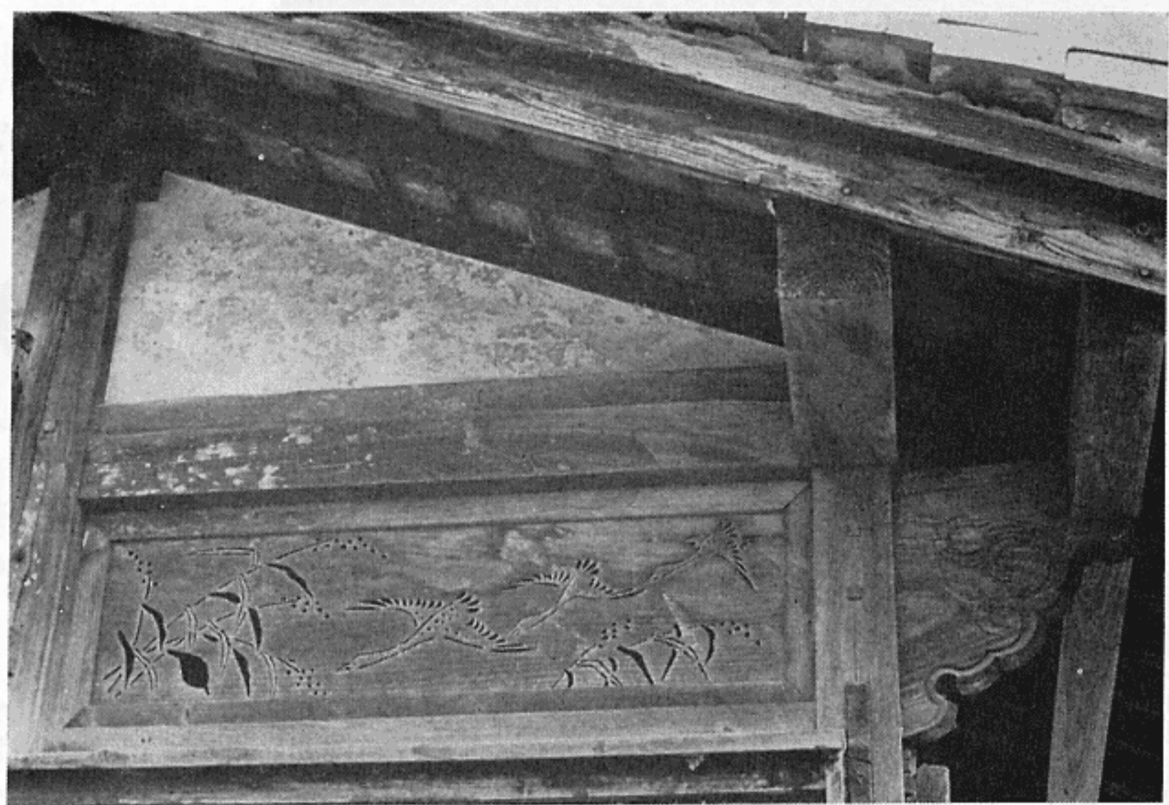
外壁にも見られる欄間
