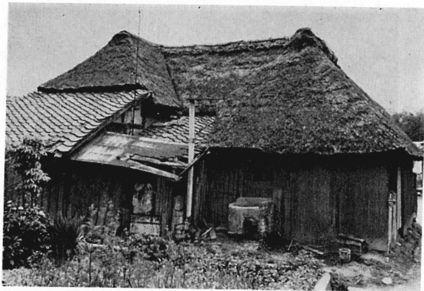
市内でみたクド造り型民家（背面）
