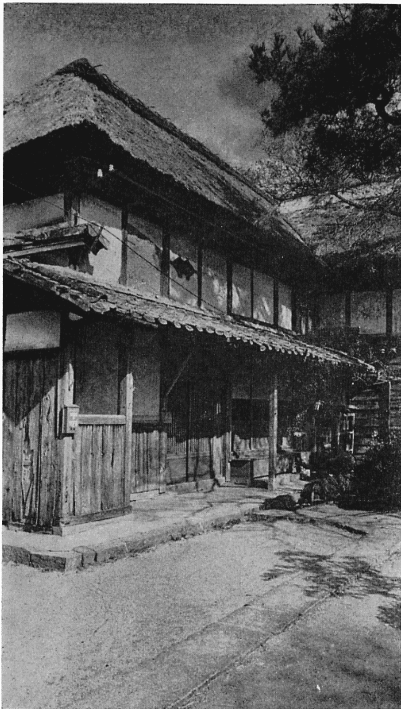
小柳典生さんの家 調査後の昭和45年12月、雨もり修理のため瓦ぶきになった
