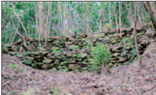
勝尾城の石垣(北から)
