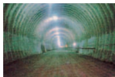
九州新幹線トンネル (建設中)
