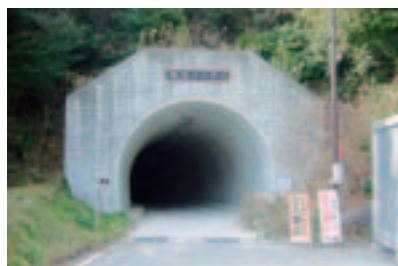
森林基幹道 (建設中)
