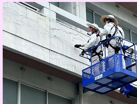
外壁調査状況（鳥栖小学校）
