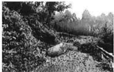
林道災害 (頭野芳谷線、河内町)
