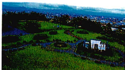
朝日山配水池
