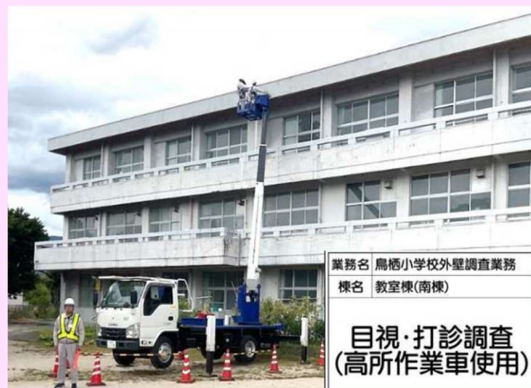
外壁調査実施状況
