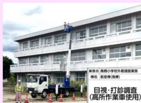
外壁調査実施状況
