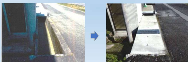
水路蓋掛け工事 施工事例
