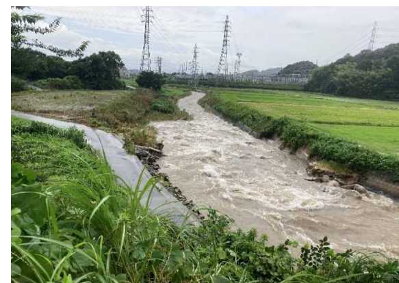
蔵上井堰 被災直後
