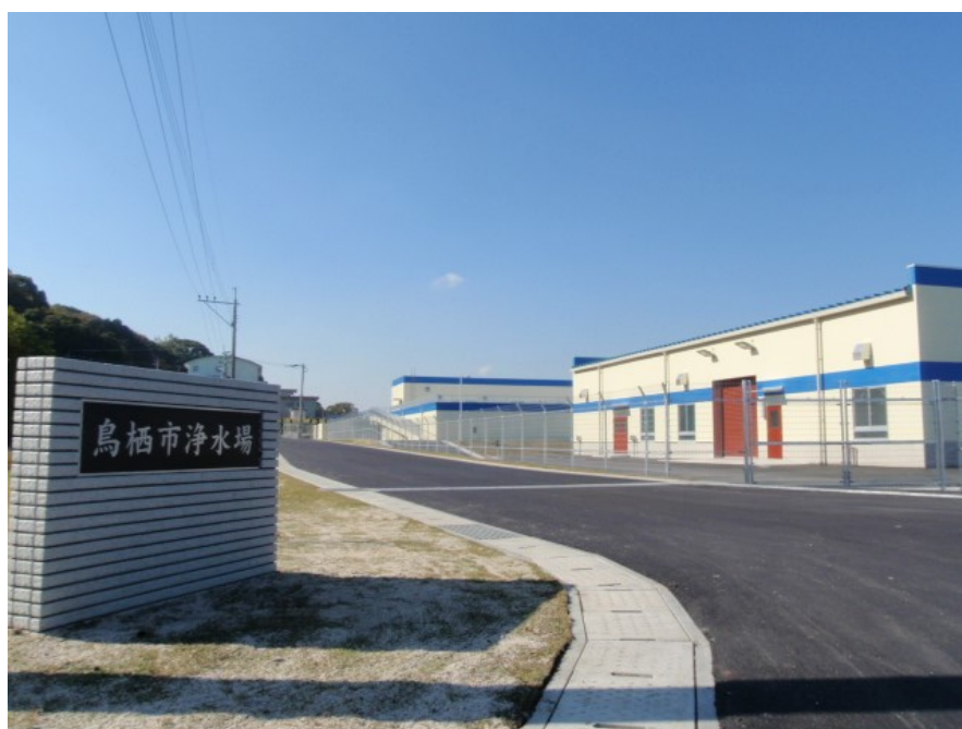
鳥栖市浄水場（鳥栖市原古賀町）
