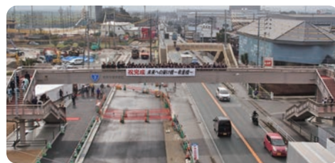
平成31年2月に架け替えが完了した歩道橋「希里橋」
