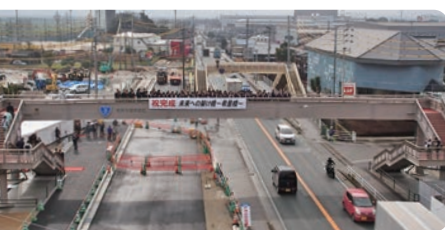
平成31年2月に架け替えが完了した歩道橋「希里橋」
