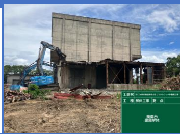
プラットフォーム 解体状況
