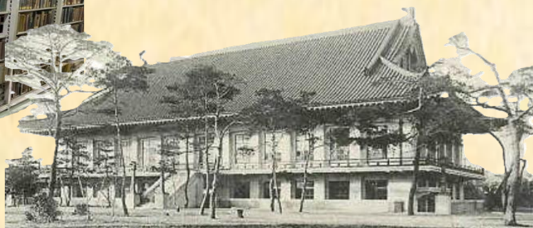
CIE図書館・福岡にあった旧武徳殿(福岡市)
