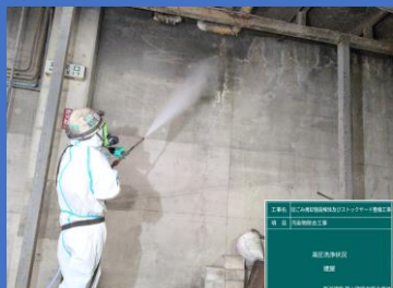
工場棟 高圧洗浄状況
